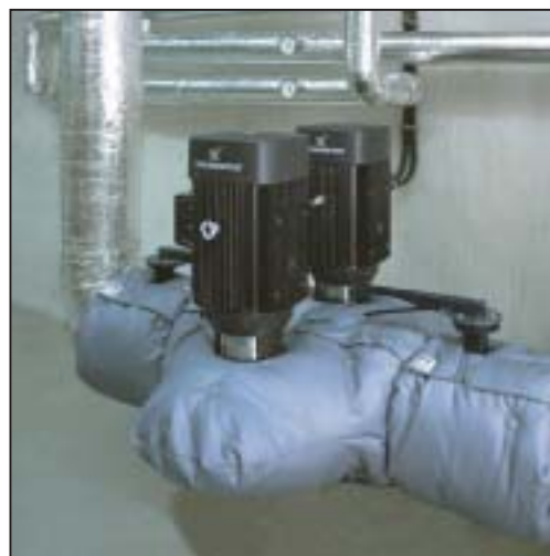
Eksempel på standardjaker og målsøm sammenmontert
